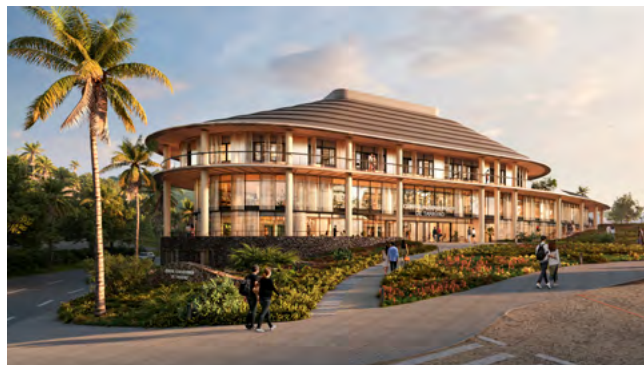
▲ Parvis d'accueil et entrée principale.
