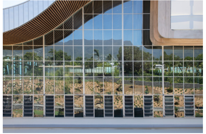
▲ Détail de la façade.
