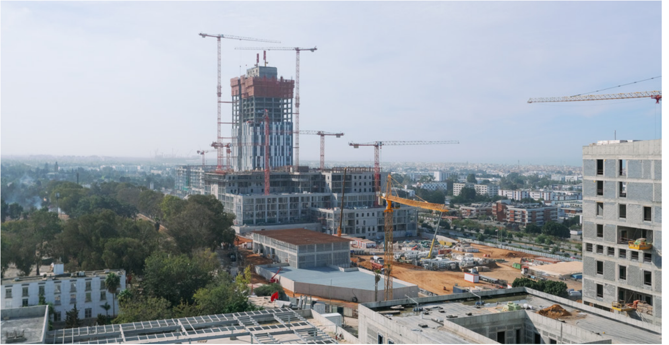
▲ Le montage de la tour en chantier (janvier 2025).
