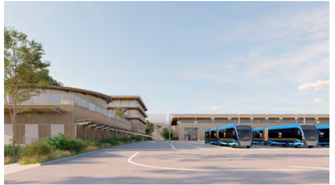
▲ Vue sur l'atelier et bâtiment restauration / salle de sport.
