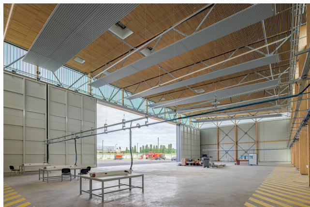
▲ Vue intérieure de la halle avionique.
