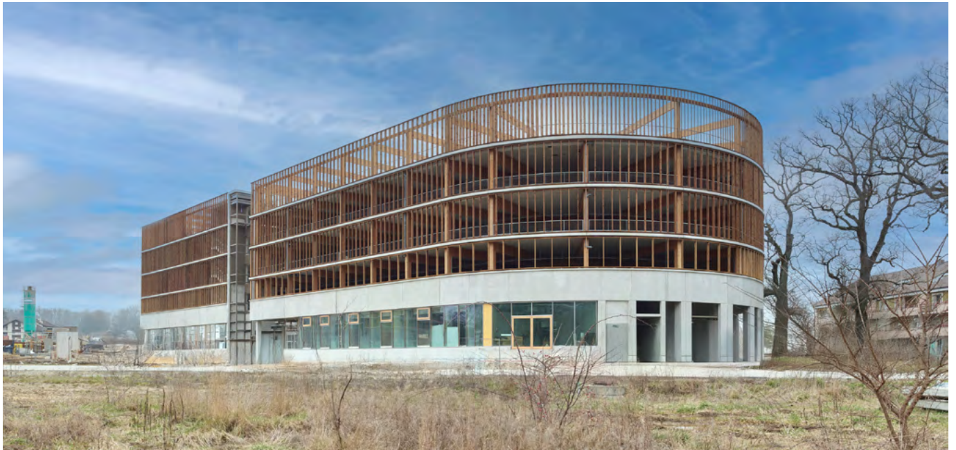
▲ Vue d'ensemble (chantier en cours).
