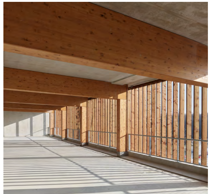
▲ Vue circulation intérieure (chantier en cours).
