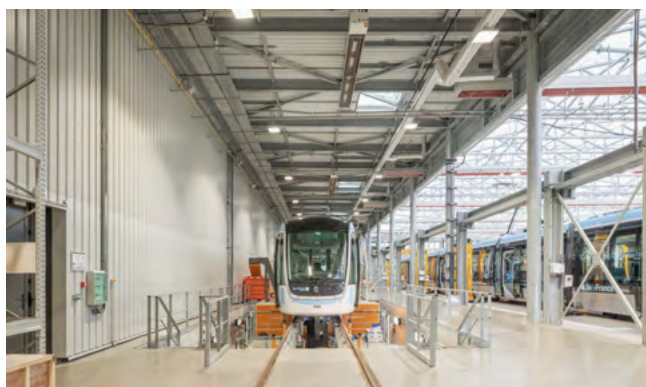
▲ Hall de maintenance, fosse.
