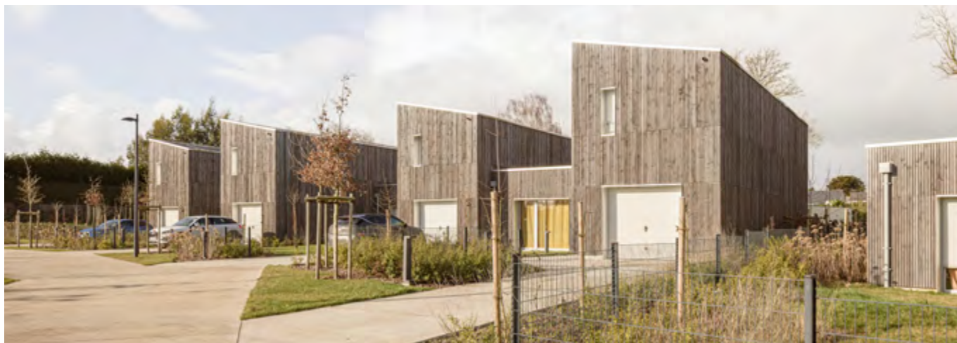
▲ Logements de fonction
