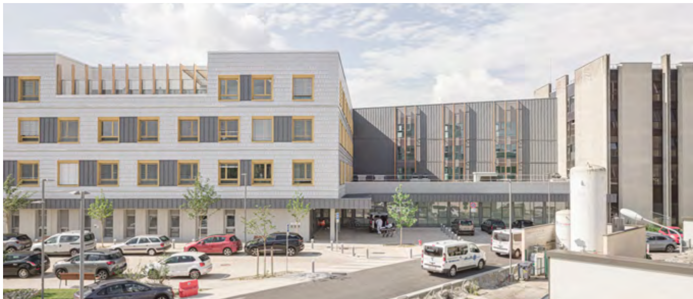
▲ Jonction du bâtiment neuf et de l'existant
